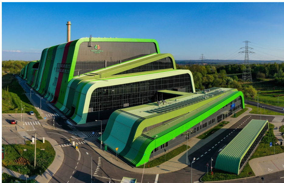
Zakład Termicznego Przekształcania Odpadów (Ekospalarnia Kraków), 2019
